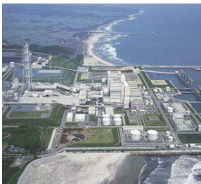
石炭火力発電所 Coal Fired Power Plant
