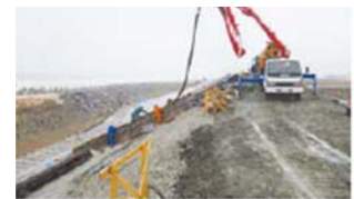
復興工事施工箇所
