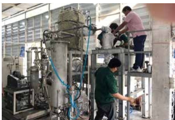
図 13 CU 研究員、職員により保守・メンテナンス
