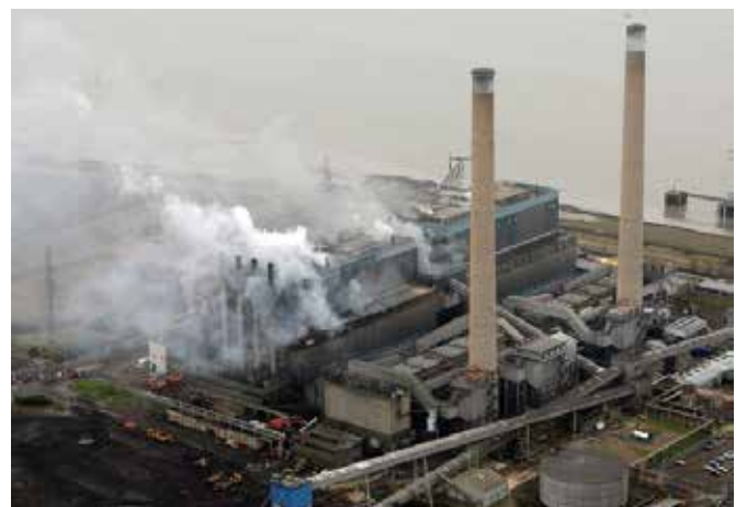
写真1 ティルベリー発電所の火災
