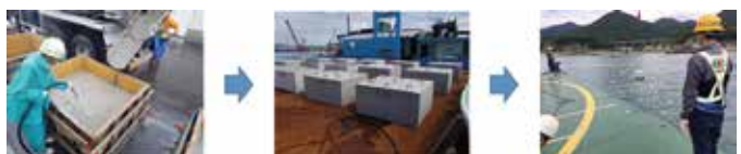
図 1 人工藻場ブロック沈設の様子
