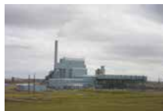
写真6 Dry Fork 発電所
