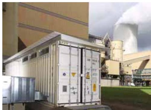
図 10 STEAG 社が建設した電力貯蔵用大容量バッテリーシステム
