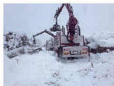
写真 3 積雪期(冬)の現場状況
