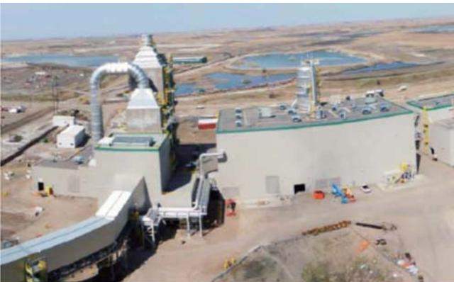
図5 Boundary Dam3のSO<sub>2</sub>、CO<sub>2</sub>吸収塔及び分離塔
