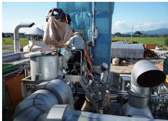
写真2 共ガス化用石炭のホッパへの充填作業
