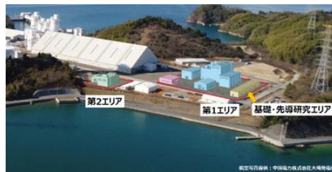
写真（左→右） 着工祈願祭の様子、拠点化のイメージ
