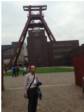
入り口正面の立坑巻上げ設備
