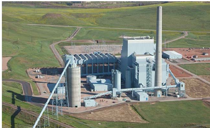
ワイオミング州 Dry Fork 発電所。煙突手前部分が試験プラント設置スペース
