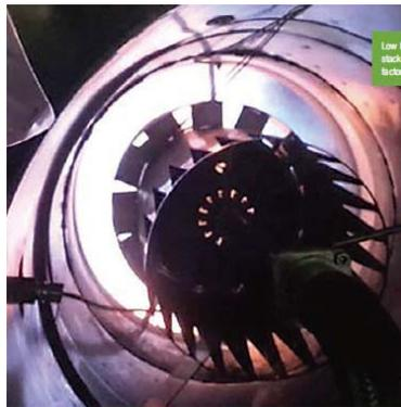
低 NO<sub>x</sub> バーナへの交換工事の状況
