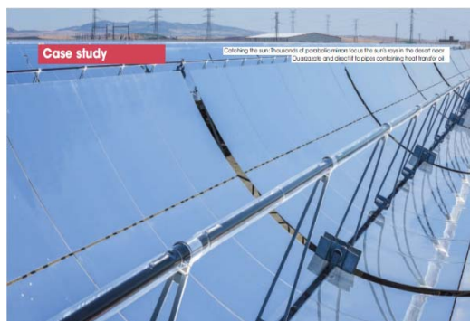
太陽熱発電所のパラボラのミラー
