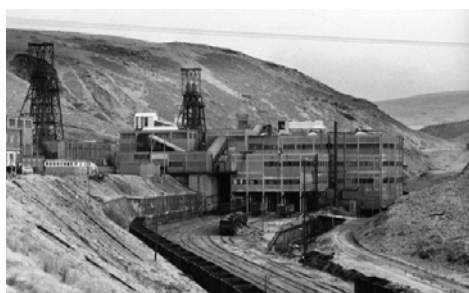
図 61 ロング渓谷現役の頃の炭坑
