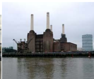
図 17 バターシー石炭火力発電所
