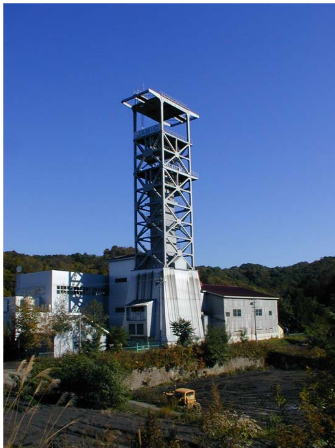
三井砂川立坑
