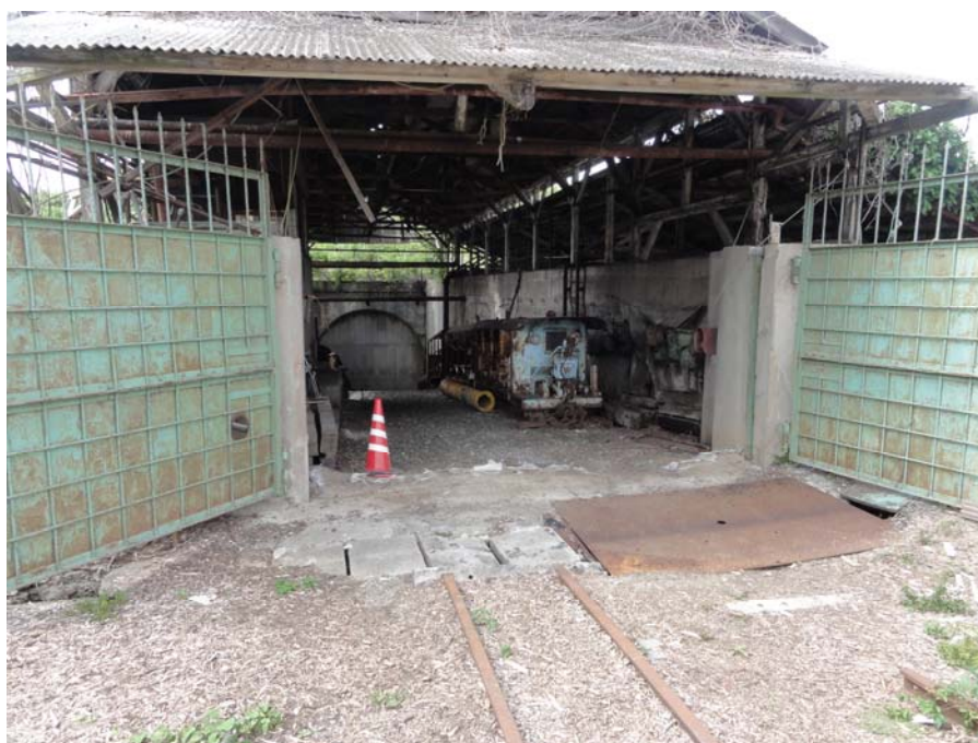
三池三川鉱斜坑
