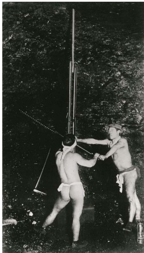
三池炭鉱 萬田坑 発破孔穿鑿作業 大正時代
