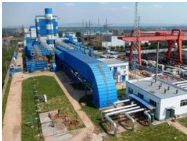
高河炭鉱 VAM 発電所(出典:米国 EPA)
