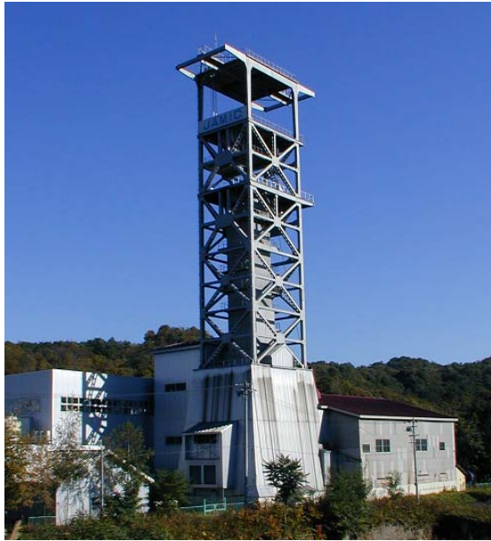
上砂川中央立坑
