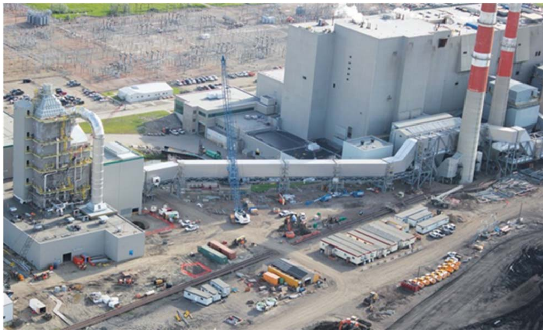
建設中の Saskpower 社 110MW Boundary Dam CCS Project
