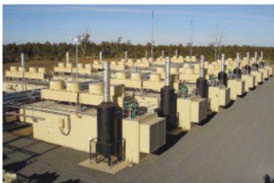
Moranbah 炭鉱の 45MW の採掘跡ガス発電設備
