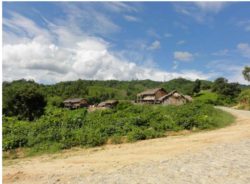
山岳部の舗装道路
