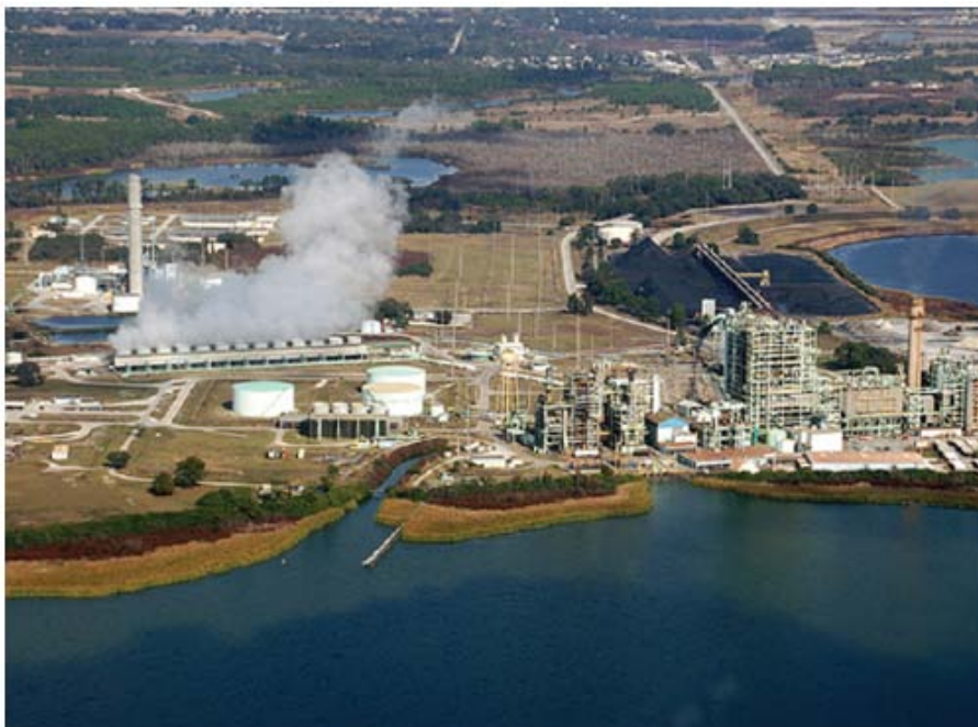
McIntosh, Jr. Power Plant (右手のユニットが石炭焚 3 号 365MW 機)
