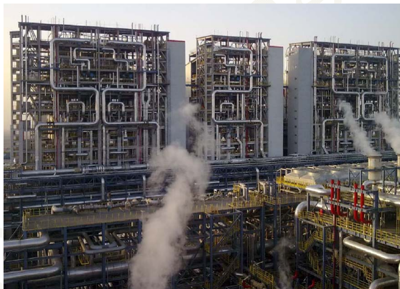
図2 神華寧煤集団の石炭MTPプラントに使用されているGSPガス化炉(5×2000t/d)の写真
