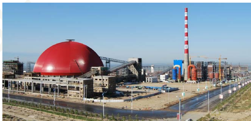
図 5 建設中の慶華集団伊犁石炭 SNG プラントの写真
