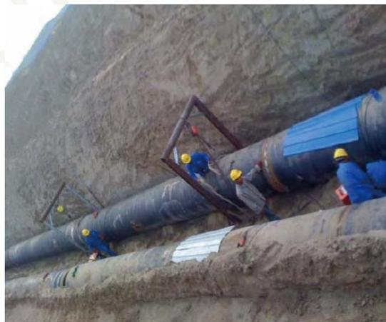
図 3 SNG 専用パイプラインの建設様子
