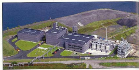
図 3 世界最大の麦わらからのバイオ エタノールプラント (100t 麦わら/day、 カルンドボルグ)
