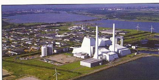
図 2 世界最大の麦わら焚き発電所 (麦わら 25 t /h 燃焼、コペンハーゲン)
