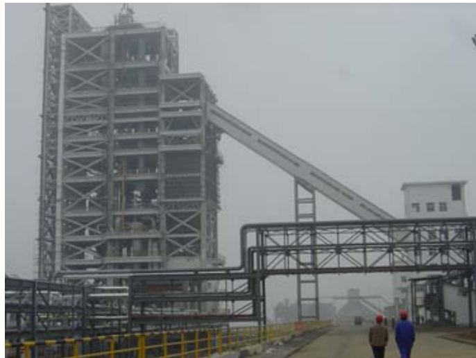
図 3 建設完了した実証プラントの写真
