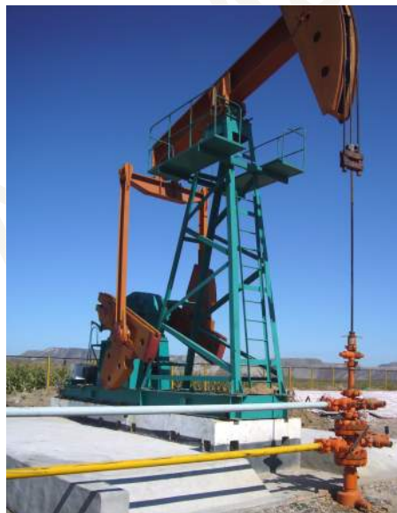
写真 依蘭県生産井
