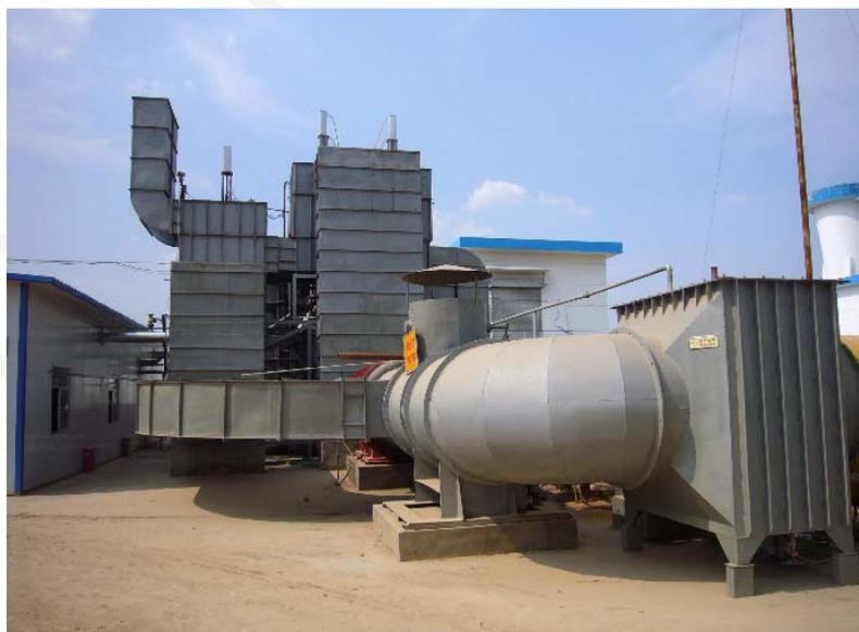
写真 大佛寺炭鉱の VAM 酸化装置
