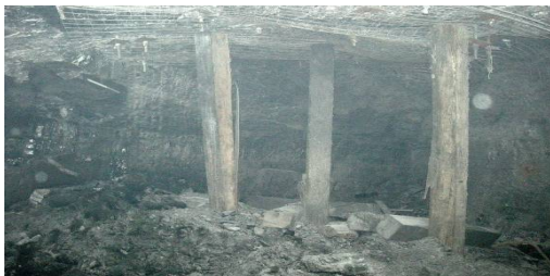
坑道交差部の天井広箇所での打柱
