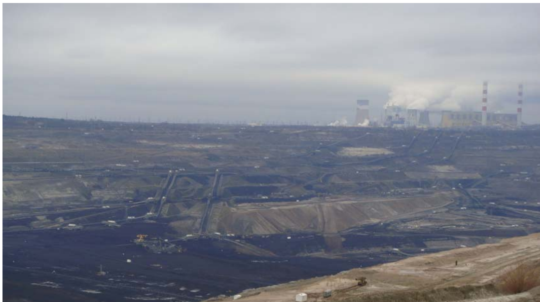
PGE の褐炭露天掘炭鉱と隣接するベルハトフ発電所
