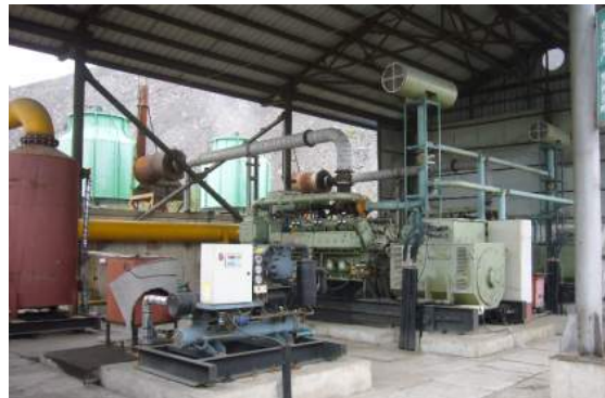
写真 低濃度ガス安全輸送試験装置及びガスエンジン
