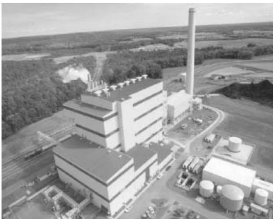
バージニア州キングジョージ郡のバーチウッド発電所では、建材用軽量骨材へのアッシュ変換スプレードライヤーの実証が行われている。
