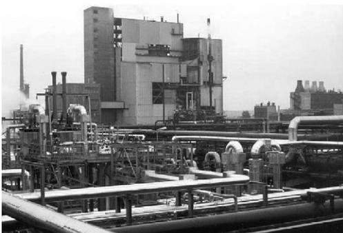
図12 SVZ「シュヴァルツェ・ブンペ」社の商業ガス化プラント(総熱容量200MW、スルーput 石炭30t/hもしくは廃油10t/h+スラリー7t/h)
