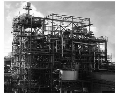
図14 シールサンズ(英国ミドルズボロー)にあるBASF社の化学廃棄物流動層ガス化プラント。能力：30MW、合成ガス13,100Nm<sup>3</sup>/h相当
