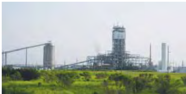
タンバIGCCプラント設備
