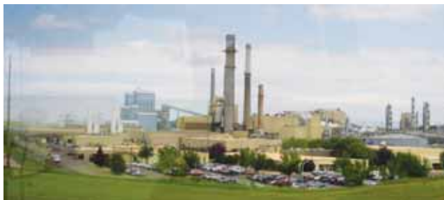
ガス化プラント全景
