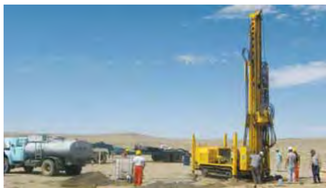
写真1 試錐調査の状況
