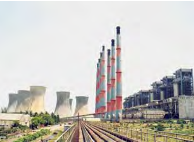
写真1 褐炭焼き山元発電所(Neyveli Lignite Corp. Ltd HP)
