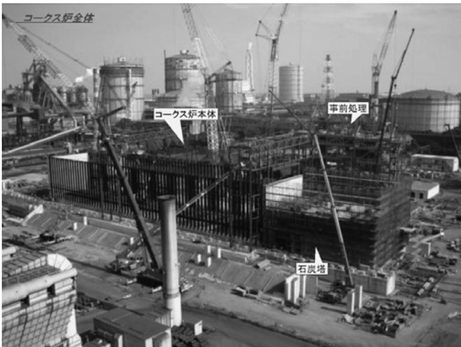
写真2 大分第5コークス炉の建設状況
