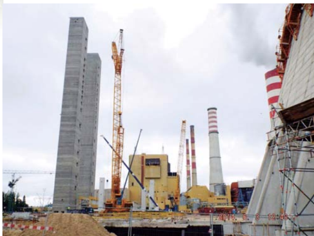
<ENEAコジェニツェ発電所(ボイラ設備の建設風景、奥は既設ユニット)>
