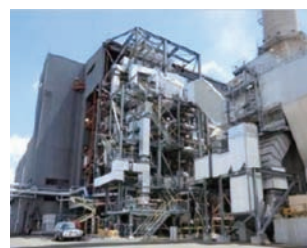
カライド発電所 酸素燃焼ボイラ
