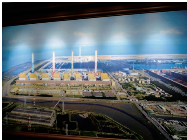
台中石炭火力発電所全景
