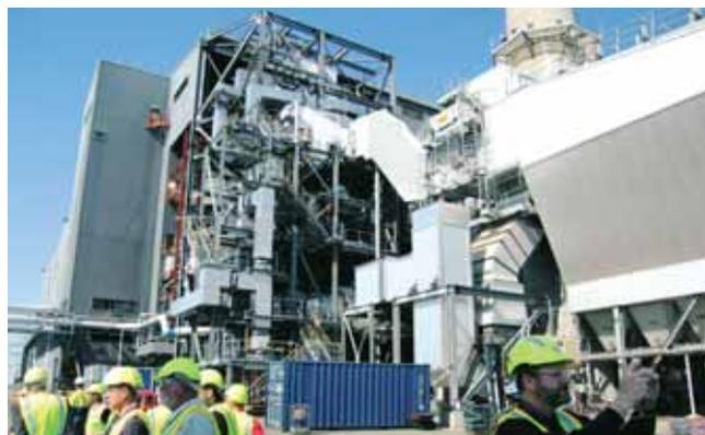
図2 Callide発電所 酸素燃焼改造ボイラ
