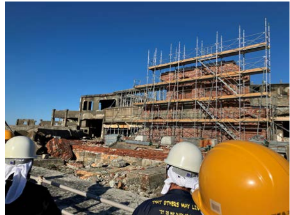
総合事務所 (第 2 見学広場より撮影※)
