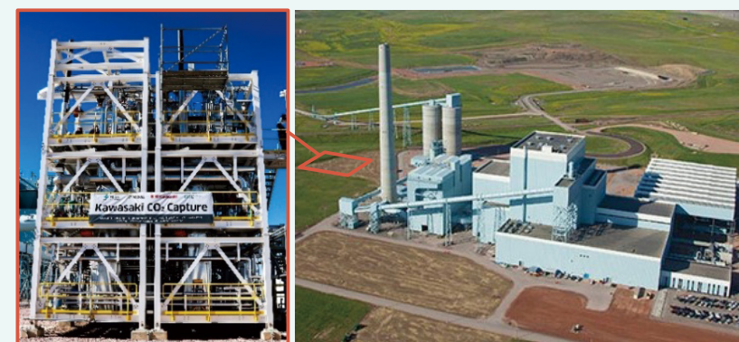
Dry Fork 発電所全景と実証試験場所 (ITC)
