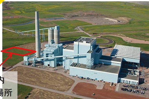
Dry Fork 発電所全景と実施試験場所 (ITC)
