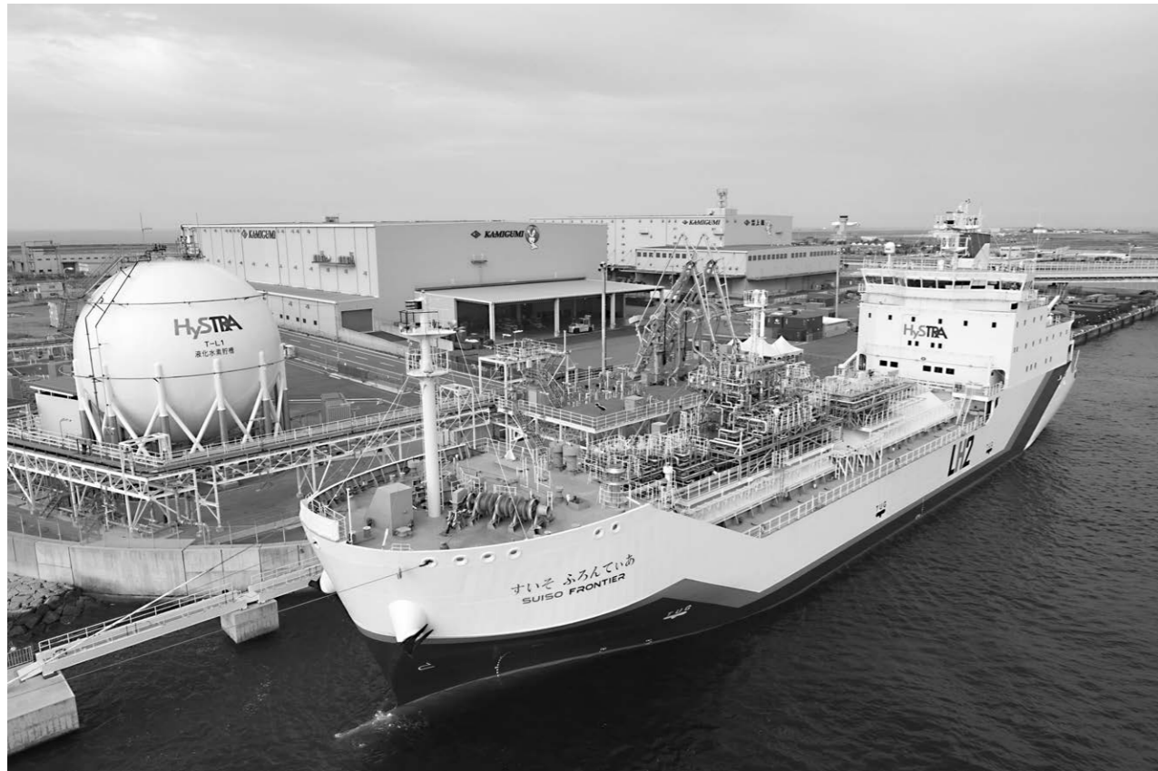
神戸空港島の世界初の液化水素荷役実証ターミナル (Hy touch 神戸) と 液化水素運搬船 (すいそふろんていあ)
