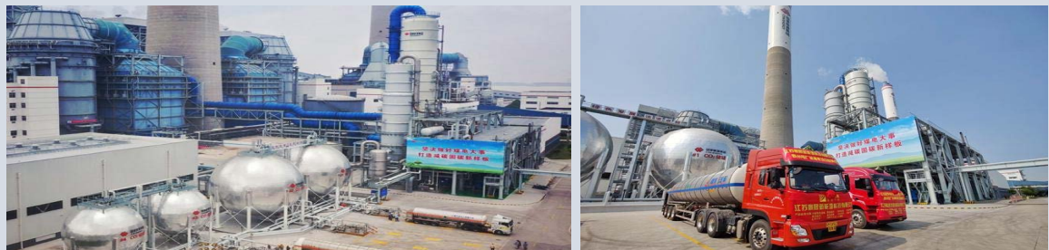
图为国家能源江苏泰州电厂4#机组50万吨CO 2 碳捕捉/碳循环利用现场
