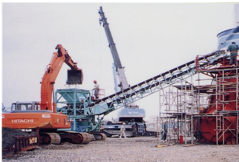
写真-2.10 新素材コンクリート（ネオ・アッシュクリート）の打設状況 8)
