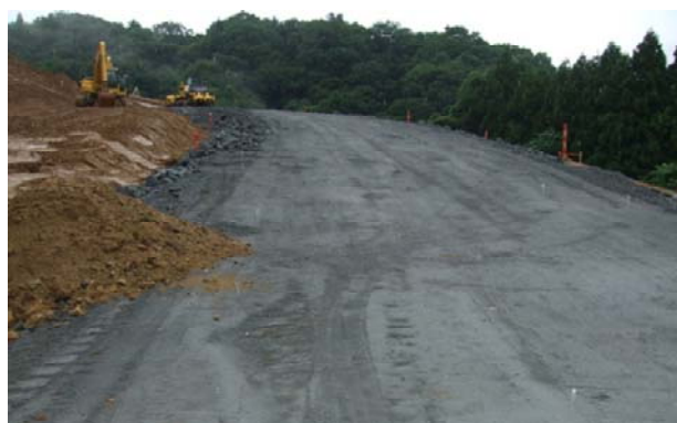
転圧完了状況（H23. 7. 29 撮影）
