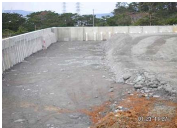
写真-3.13 L型擁壁裏込施工状況(2)
