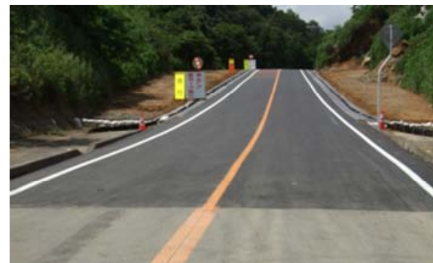
復旧完了の状況（H23. 8. 31 撮影）
