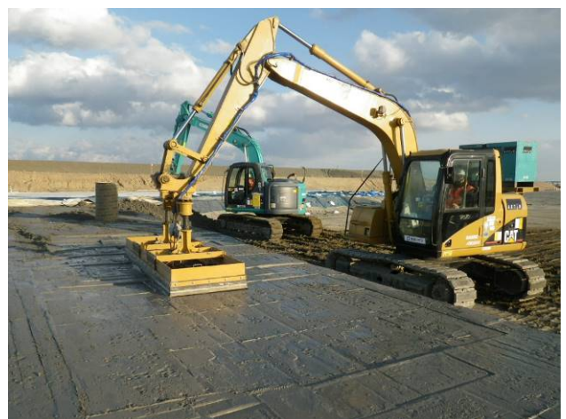
写真-3.8 専用機器による振動締固め
