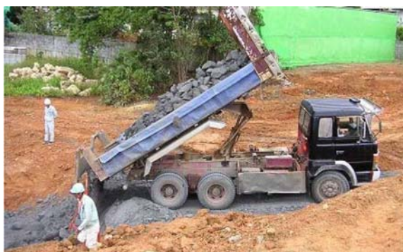
写真-3.10 置換工施工状況(1)
