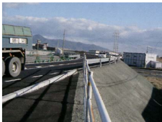
写真-2.9 クリンカアッシュ使用例（軽量盛土工）
