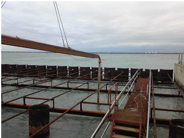
写真-2.6 スラリー材（Fスラリー）打設状況
