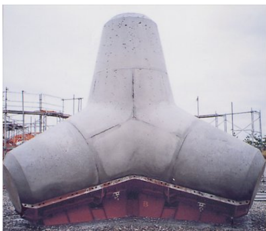
写真-2.11 完成した消波ブロックとコアの状況 8)
