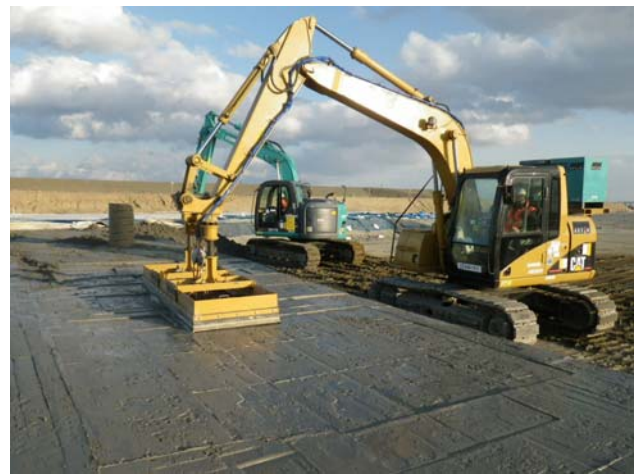
写真-2.5 塑性材（アッシュクリート TypeⅡ）の運搬と締固めの状況
