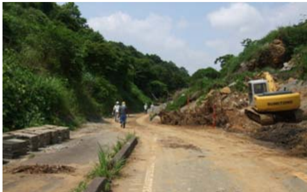
復旧工事開始（H23. 7. 25 撮影）
