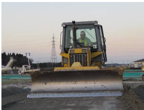
写真-3.4 ブルドーザによる敷ならし
