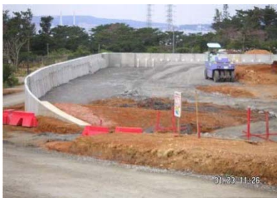
写真-3.12 L型擁壁裏込施工状況(1)
