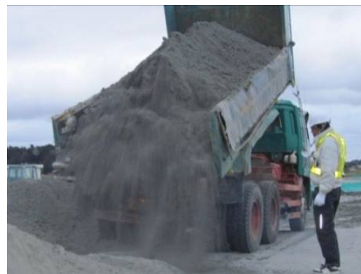
写真-3.3 ダンプトラックによる運搬
