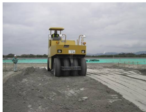
写真-3.5 タイヤローラによる締固め
