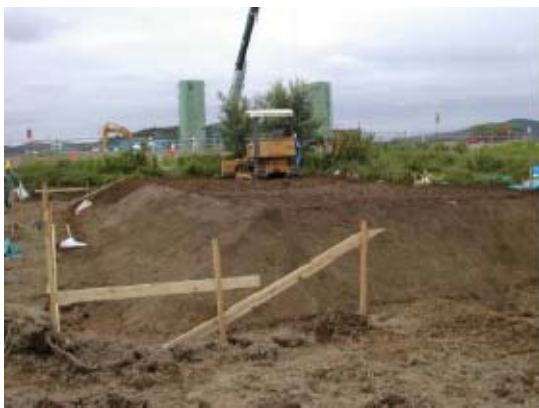
写真-2.8 混合盛土の施工例
