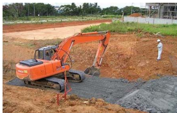
写真-3.11 置換工施工状況(2)
