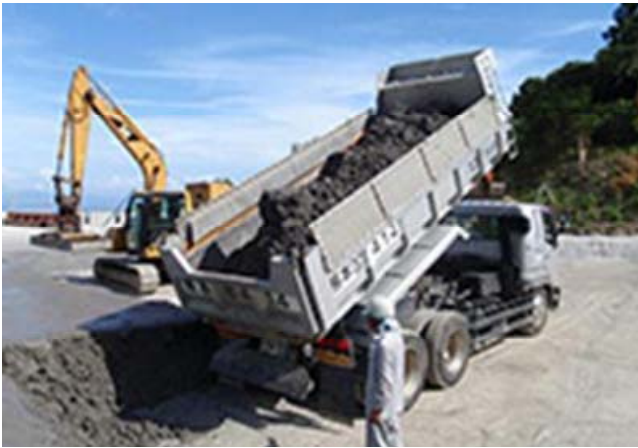
写真-3.6 塑性材の運搬と締固めの状況
