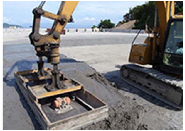
写真-3.6 塑性材の運搬と締固めの状況
