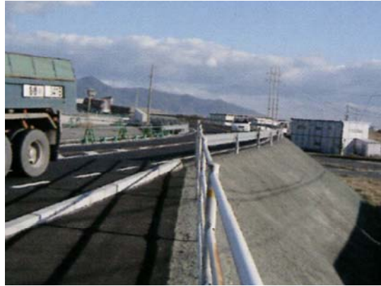
写真-3.10 クリンカアッシュ使用例（軽量盛土工）
