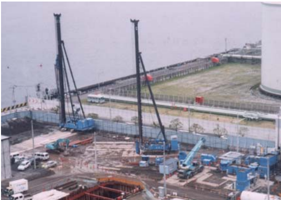
CDM-FGC 処理機の地盤改良状況
