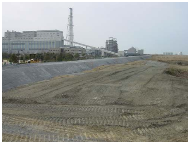
材料巻き出し嵩上げ状況
