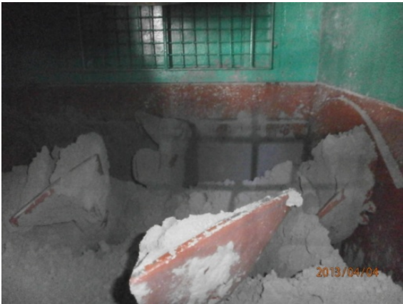
写真-3.5 塑性材の製造プラントの攪拌混合の状況
