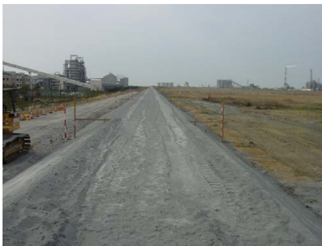
材料巻き出し嵩上げ状況
