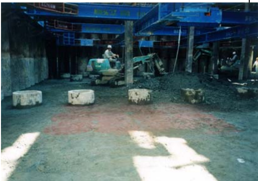
地盤改良後、切梁施工し底盤まで掘削撤去している状況
