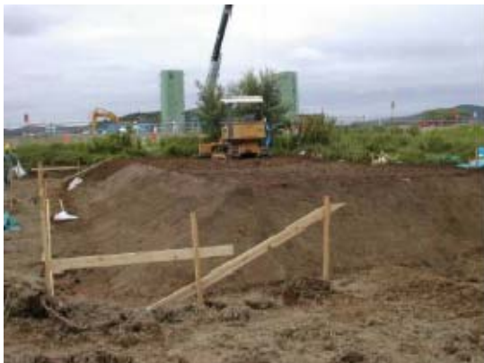
写真-2.9 混合盛土の施工例
