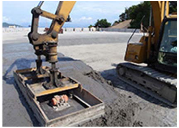
写真-2.6 塑性材の運搬と締固めの状況
