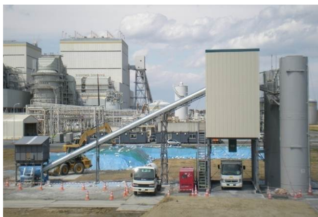
写真-2.5 塑性材の製造プラントの攪拌混合の状況
