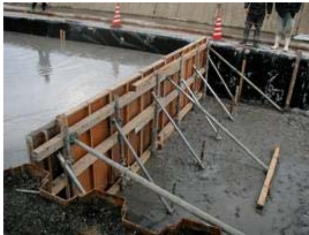
写真-4.1 型枠設置状況
