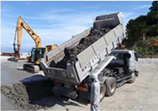
写真-2.6 塑性材の運搬と締固めの状況
