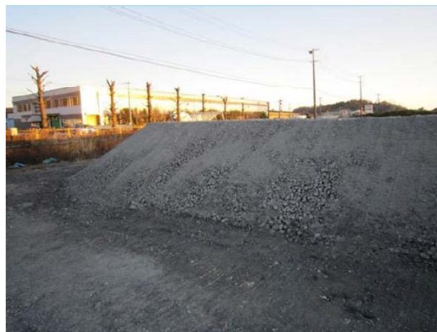
写真-2.2 破砕材（J-アッシュ）の養生状況
