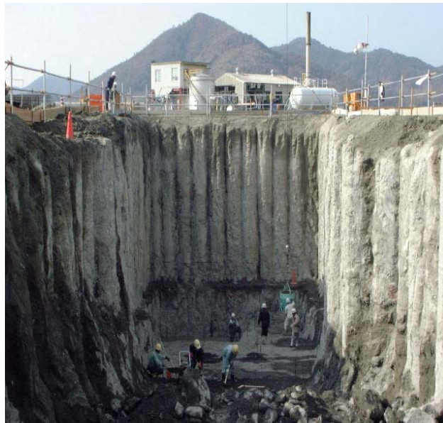
写真-4.2 スラリー材による地盤改良
