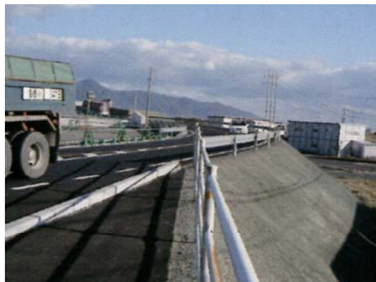
写真-2.10 クリンカアッシュ使用例（軽量盛土工）
