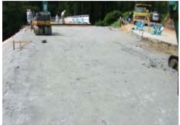
転圧状況 (H23. 9. 16 撮影)
