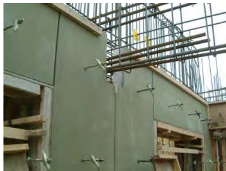
写真-2.45 外断熱パネル施工状況 (フライアッシュ GP パネル)
