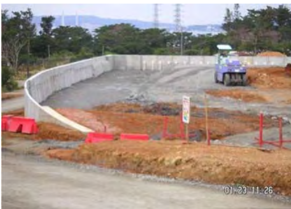
写真-2.42 L型擁壁裏込施工状況(1)
