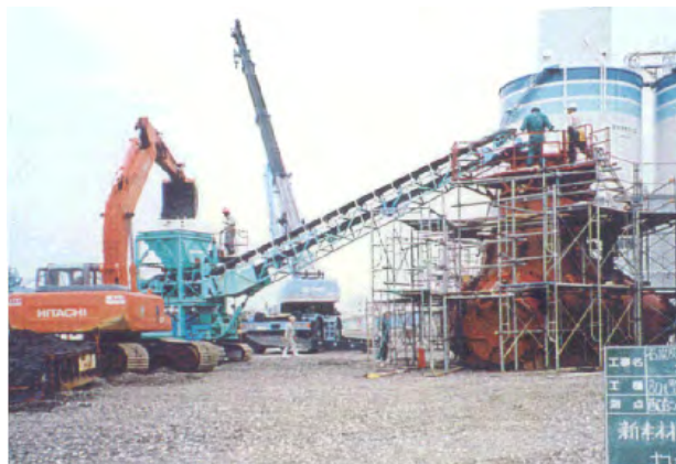
図-2.53 テトラポッドの型枠バイブレータの設置事例
