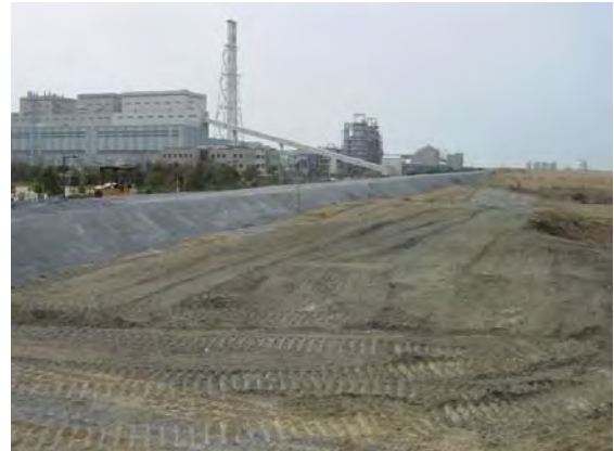
写真-2.24 石炭灰混合材料（造粒材）築堤延長状況
