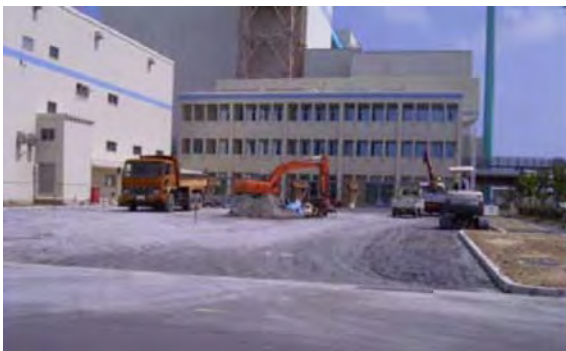
写真-2.36 施工状況全景
