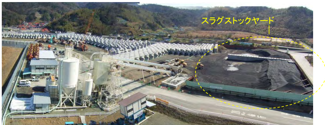
写真-2.49 製造設備の状況
