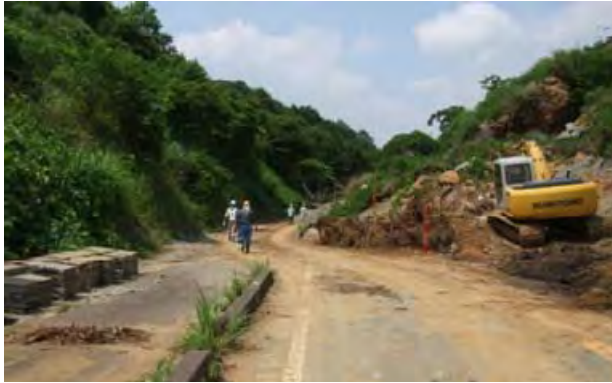
復旧工事開始 (H23. 7. 25 撮影)
