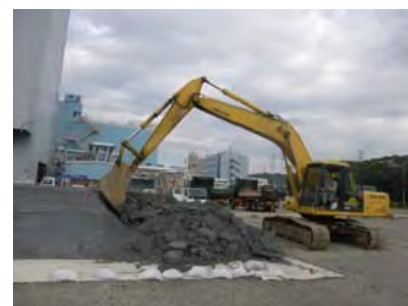
写真-2.19 石炭灰混合材料の固化体（頑丈土）の製造、破砕材の製造
