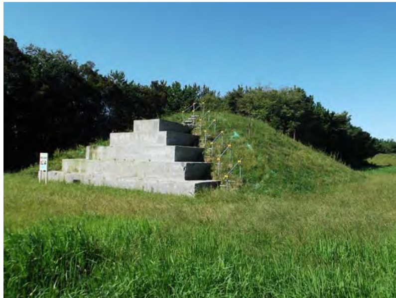
写真-2.15 防潮堤盛土の全景
