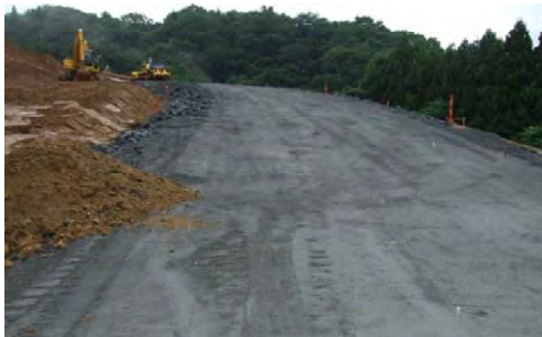
転圧完了状況 (H23. 7. 29 撮影)
