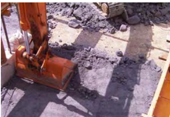
写真-2.38 敷ならし状況
