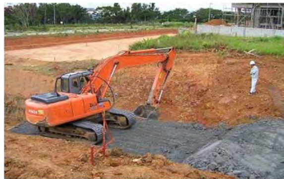
写真-2.41 置換工施工状況(2)
