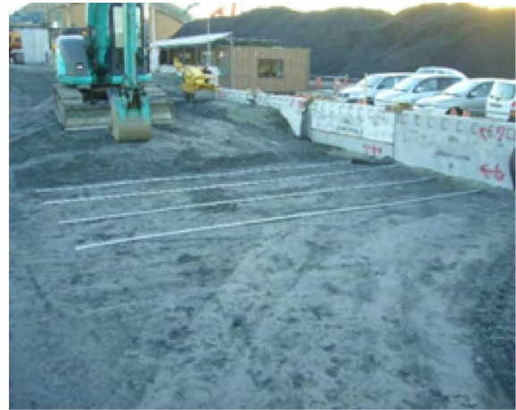
写真-2.31 裏込土施工状況 (その1)
