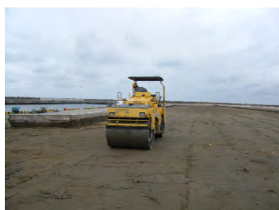
写真-2.22 完了全景（基盤、固化体破砕材下層路盤、上層路盤）
