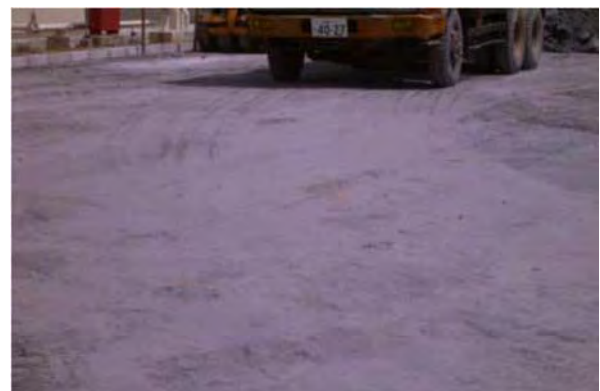
写真-2.39 転圧状況
