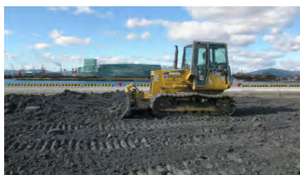
写真-2.21 ブルドーザ、モータグレーダによるまき出し状況
