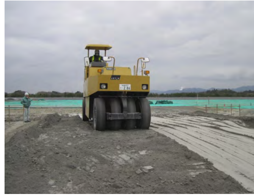
写真-2.4 タイヤローラによる締固め
