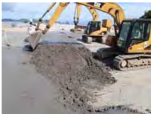
写真-2.7 バックホウによる敷ならし
