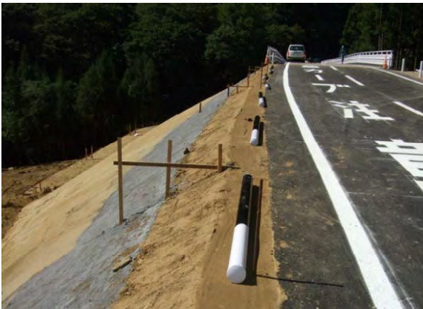
復旧完了の状況 (H23. 9. 18 撮影)
