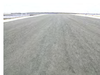
写真-2.22 完了全景（基盤、固化体破砕材下層路盤、上層路盤）
