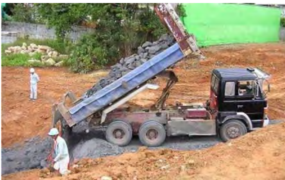
写真-2.40 置換工施工状況(1)
