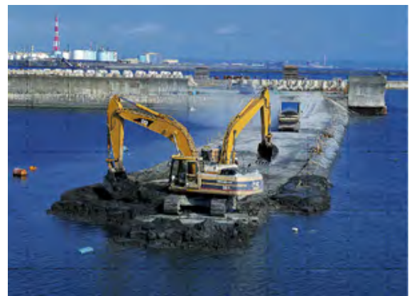
写真-2.30 石炭灰混合材料（塑性材）のまき出し状況
