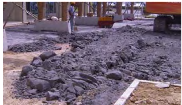
写真-2.37 材料搬入状況
