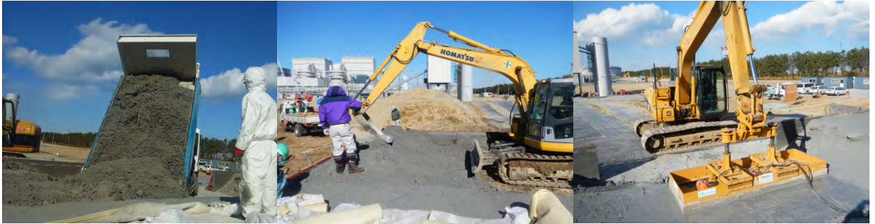
ダンプトラックによる運搬
