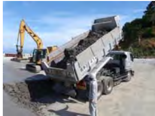
写真-2.6 ダンプトラックによる運搬
