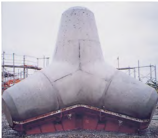
写真-3.6 完成した消波ブロックとコアの状況 5)
