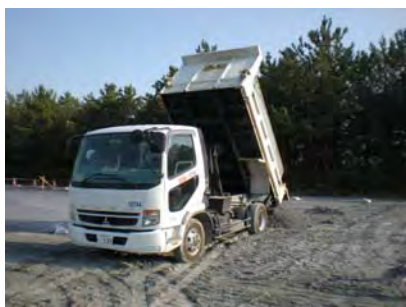
ダンプトラックによる運搬
