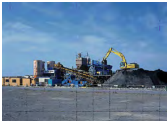
写真-2.29 混合機への土砂、石炭灰、添加材投入状況
