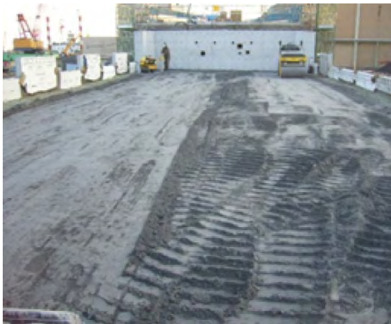
写真-2.32 裏込土施工状況 (その2)
