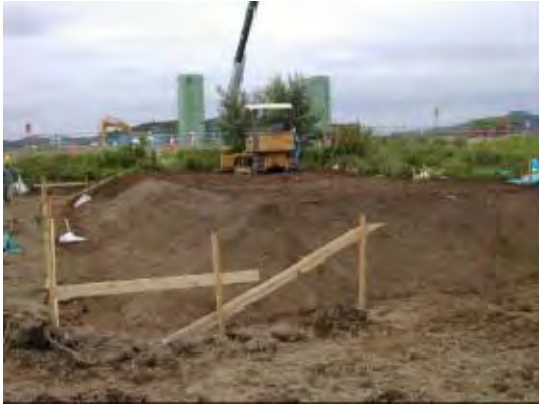
写真-3.11 混合盛土の施工例
