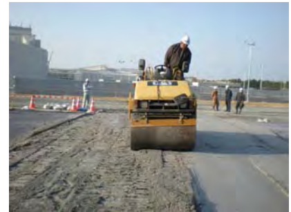
コンバインドローラによる締固め
