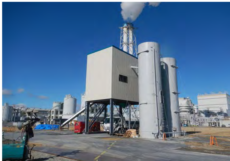
写真-2.13 バッチャープラント
