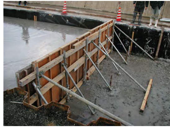
写真-2.28 護岸背面3・4段目スラリー投入状況
