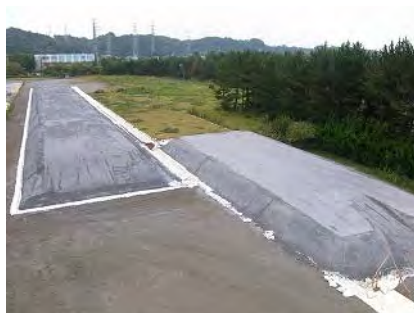
写真-2.19 石炭灰混合材料の固化体（頑丈土）の製造、破砕材の製造
