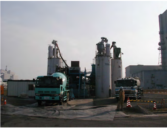
写真-2.25 スラリー製造プラントから積出
