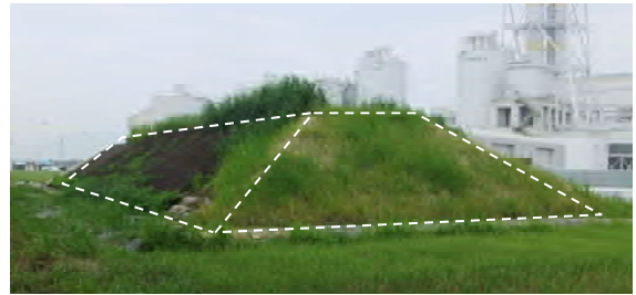
写真-2.12 防潮堤盛土の全景
