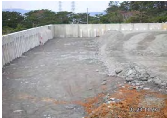
写真-2.43 L型擁壁裏込施工状況(2)
