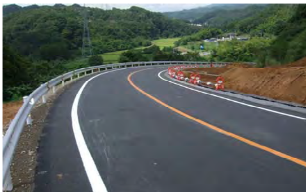
復旧完了の状況 (H23. 8. 31 撮影)
