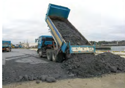
写真-2.20 ダンプカーによる材料運搬
