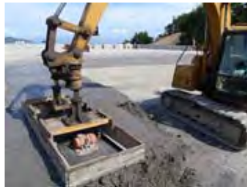
写真-2.8 専用機器による振動締め
