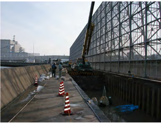
写真-2.27 護岸背面掘削状況
