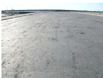
写真-2.22 完了全景（基盤、固化体破砕材下層路盤、上層路盤）
