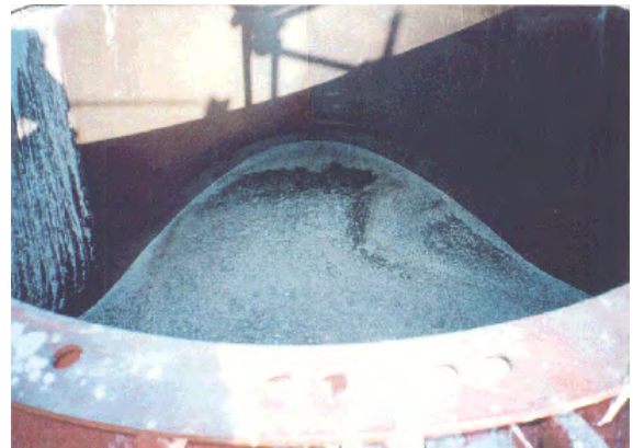
図-2.53 テトラポッドの型枠バイブレータの設置事例
