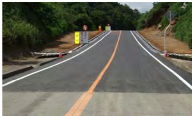
復旧完了の状況 (H23. 8. 31 撮影)
