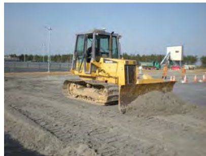
ブルドーザによる敷ならし
