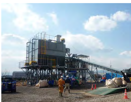
写真-2.1 石炭灰混合材料製造プラント
