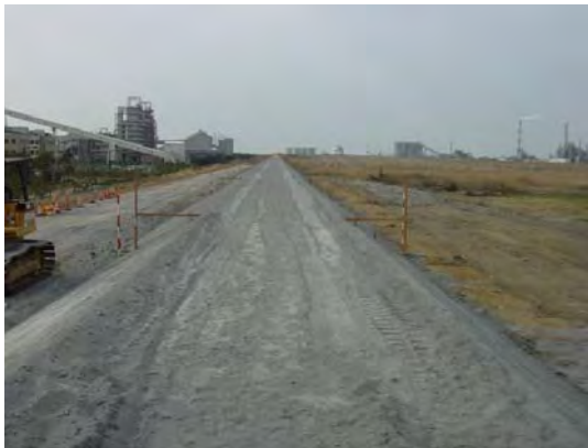
写真-2.23 材料まき出しかさ上げ状況
