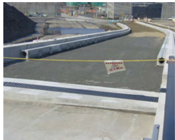
写真-2.33 施工完了
