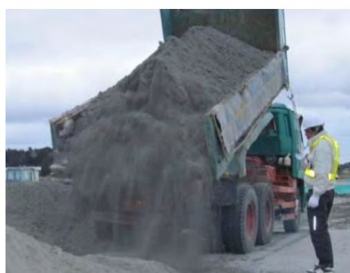
写真-2.2 ダンプトラックによる運搬
