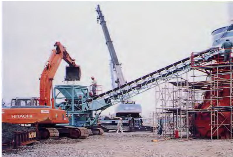
写真-3.5 消波ブロック用コンクリート（ネオアッシュクリート）の打設状況 5)
