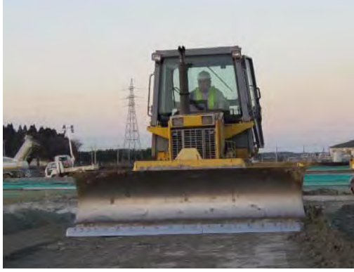
写真-2.3 ブルドーザによる敷ならし
