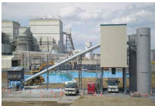
写真-3.7 改良盛土材の製造プラントの攪拌混合の状況
