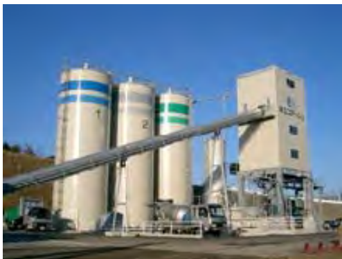
写真-2.5 石炭灰混合材料製造プラント
