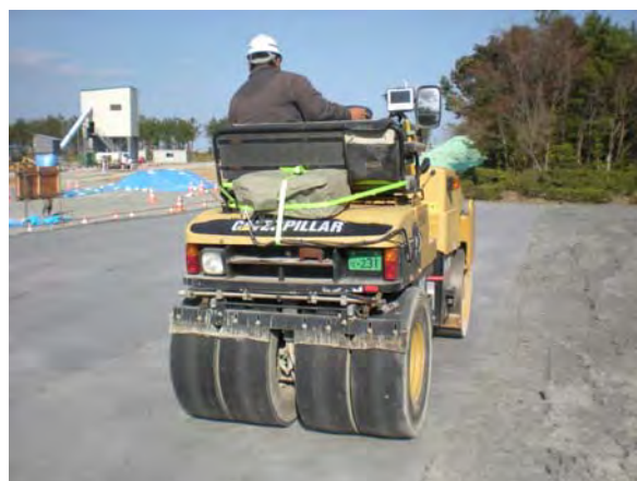
写真-3.8 改良盛土材の敷均しと締固めの状況
