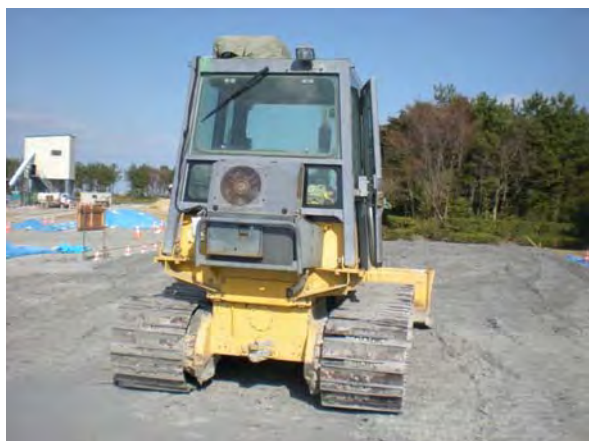
写真-3.8 改良盛土材の敷均しと締固めの状況
