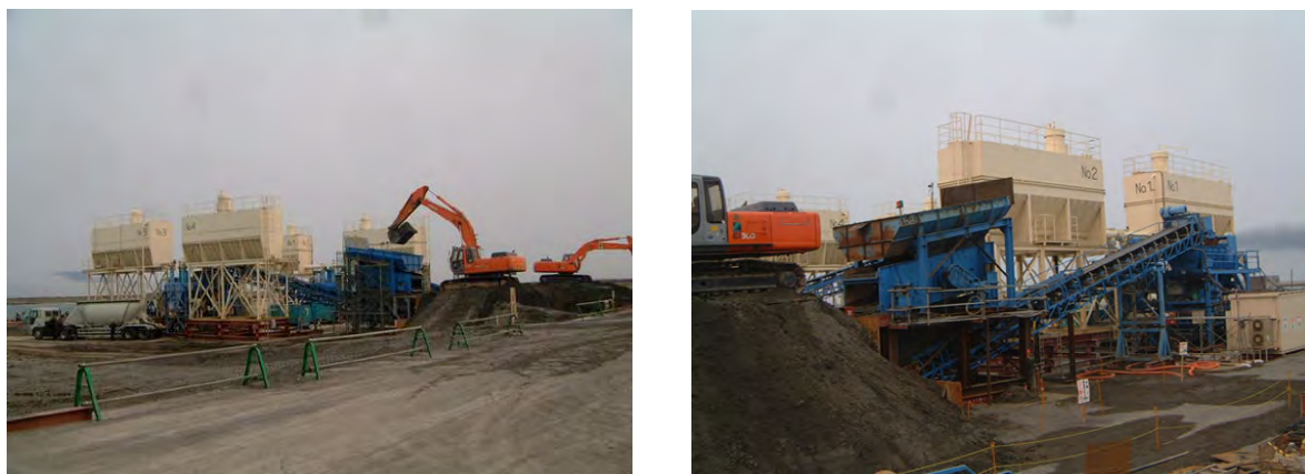
写真-3.9 浚渫土投入・混練状況
