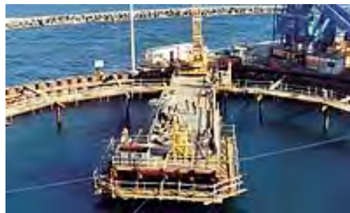
写真-2.35 石炭灰スラリー打設状況
