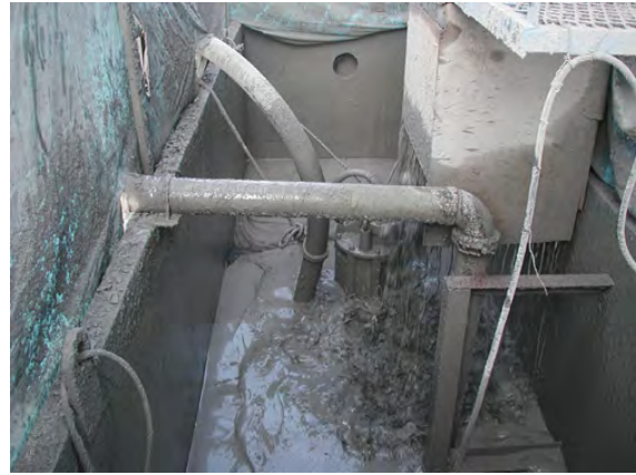
写真-2.26 スラリー状況・アジテータの内部
