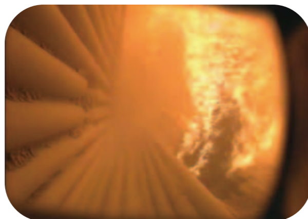
ボイラー内での微粉炭の着火
