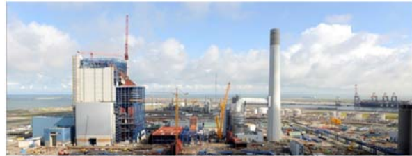
図 2 建設中の Maasvlakte 発電所 3 号機
