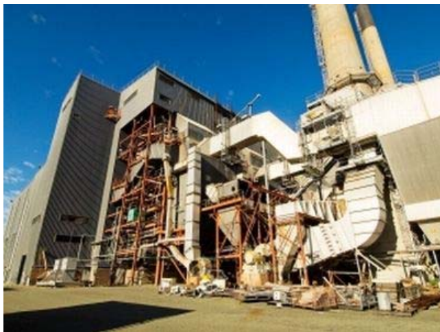
カライド酸素燃焼プロジェクト現場
